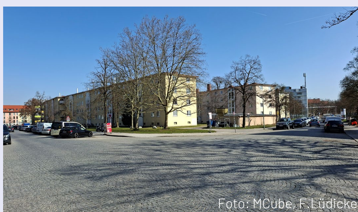
Bestand: weiter, versiegelter Kreuzungsbereich
