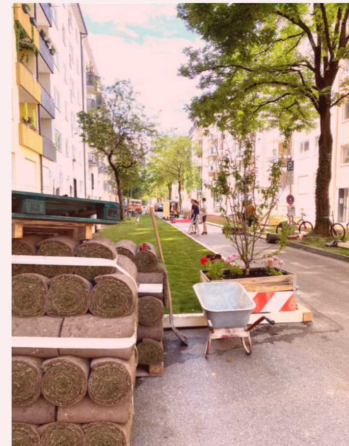
Aufbau Begegnungswiese in der Kolumbusstraße (Juni 2023)
